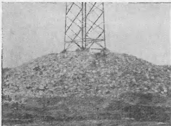
Рис. 5. Ледорезная защита с бутовым мощением призмы.
